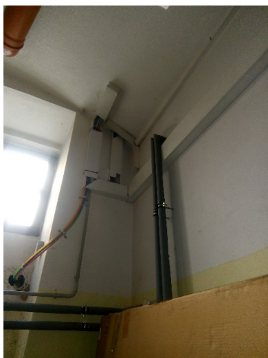
Stávající plastový kanál ve skladu
