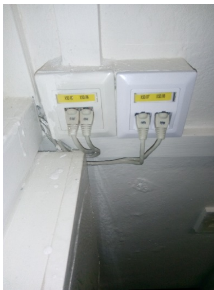
Stávající pracovní místo bude zrušeno kabely budou ponechány nad podhledem
