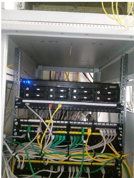
Volná pozice pro propojovací panel nad NVR
